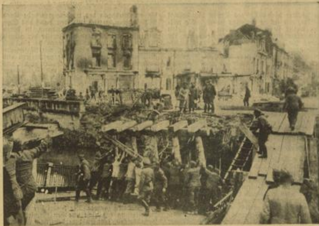
Pioniere beim Bau einer Brücke am Mühlenbach in Rethel
