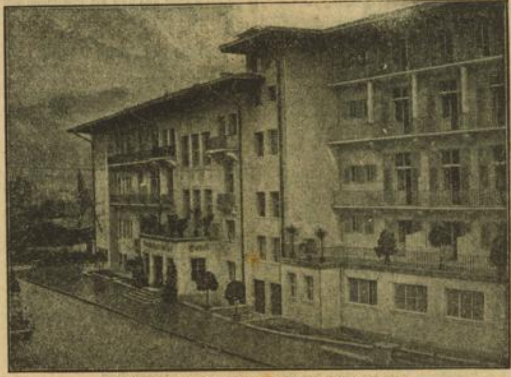
Das Gästehaus der Partei und des Führers in Berchtesgaden In einer einzigartig schönen Landschaft entstand der jetzt eingeweihte „Berchtesgadener Hof“ in Berchtesgaden, das ehemalige „Grand-Hotel“, nennmehr als Gästehaus für den Führer und die Partei in nicht zu weiter Entfernung des Obersalzberges. Das von Prof. Michaelis ausgestaltete Haus steht jedoch als Hotelbetrieb auch der Allgemeinheit zur Verfügung. (Scherl-Bilderdienst-M)
