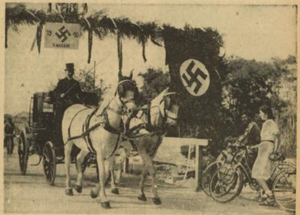
Zwei Schimmel mit der „Chaise“ passieren die neue Brücke Die neue Brücke, die die Verbindung mit dem größten Straßburger Vorort, Neudorf, herstellt, wurde von der Technischen Rothhilfe erbaut. Als erste gartien die beiden Schimmel als „Belastungsprobe“ über das Werk der tapferen Männer.
