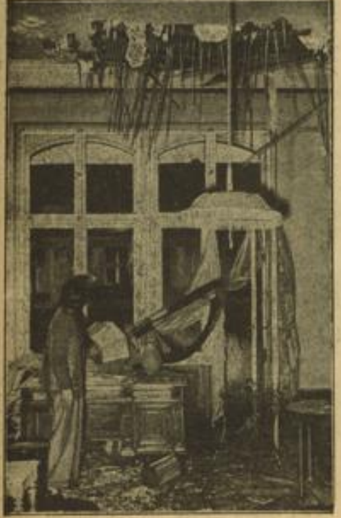
Hier hat eine Bombe das Dach eines Wohnhauses durch- schlagen und die darunterliegende Wohnung stark be- schädigt. (Aufnahmen: Scherl-Bilderdienst-M)
