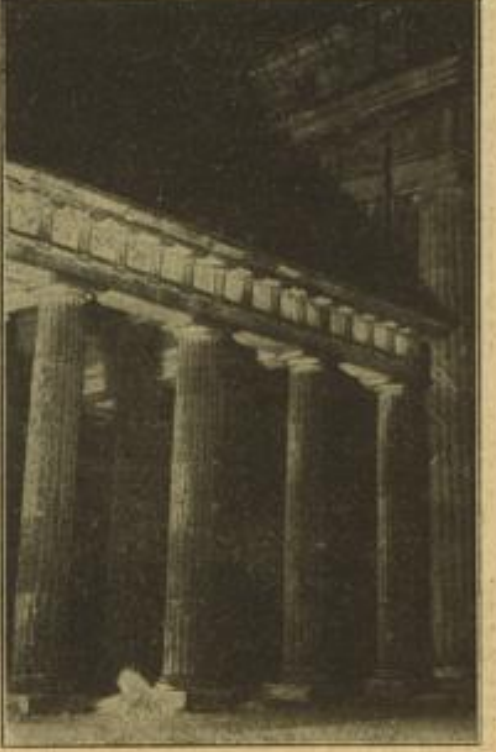
Unser Bild zeigt die Brandbombe, die die Decke des Brandenburger Tors durchschlugen hatte und dann am Boden abbrannte.
