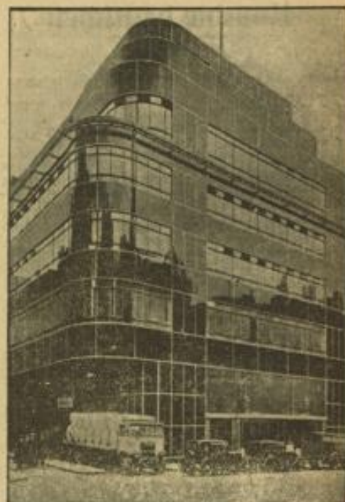
Das Gebäude der englischen Zeitung — „Daily Express“, das — wie aus London berichtet wird — bei einem deutschen Bombenangriff beschädigt worden sein soll. Weibild (M)
