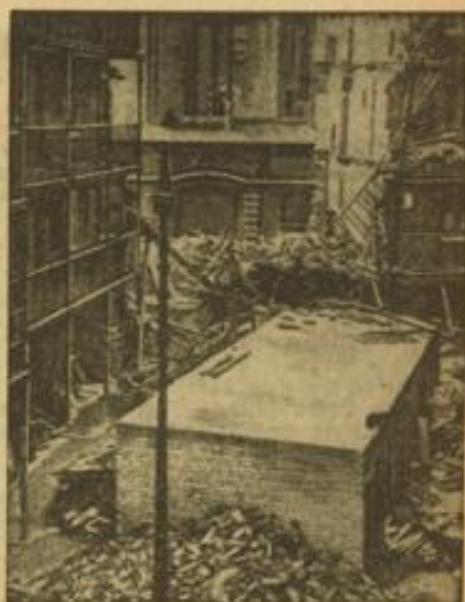
So sah es in London schon vor mehreren Monaten aus. Dieses Bild von nicht näher bezeichneten Gebäuden ist bereits am 21. 9. 40 aufgenommen worden. Wenn man bedenkt, daß sich schon damals die Schuttmassen in den Londoner Straßen häuften, kann man sich eine Vorstellung machen, wie es wohl heute nach den großen Vergeltungsangriffen in London aussehen wird. (Associated-Press-M)
