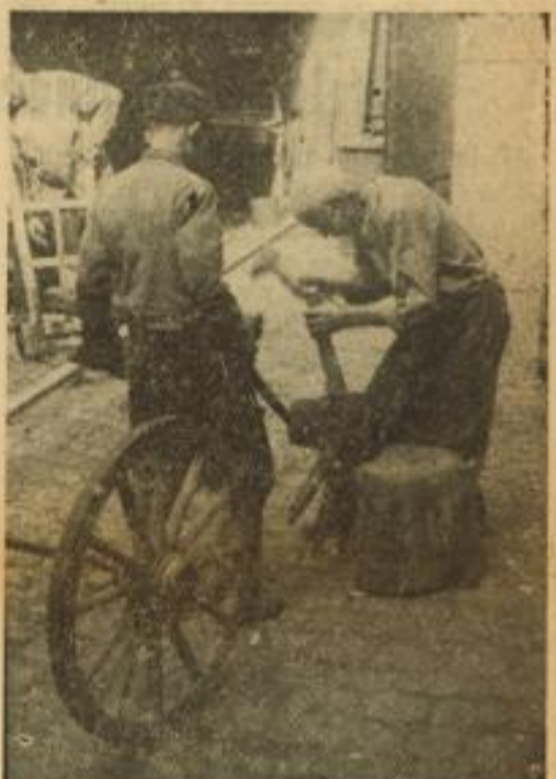
Ein paar neue Speichen und das Rad kann wieder rollen Aufnahme: Bantsh
