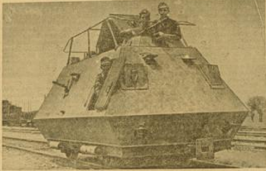
Auf Posten am Schienenstrang Dieser neue Panzersicherungswagen begleitet die Züge auf gefährdeten Strecken und schützt vor unerwarteten Überfällen. (PK-Aufnahme; Kriegsbericht Gewe (Wa))
