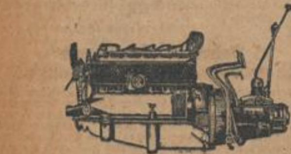
8/88 PS Zweifahrer-Motor von Daimler-Benz (Vergaserseite)
