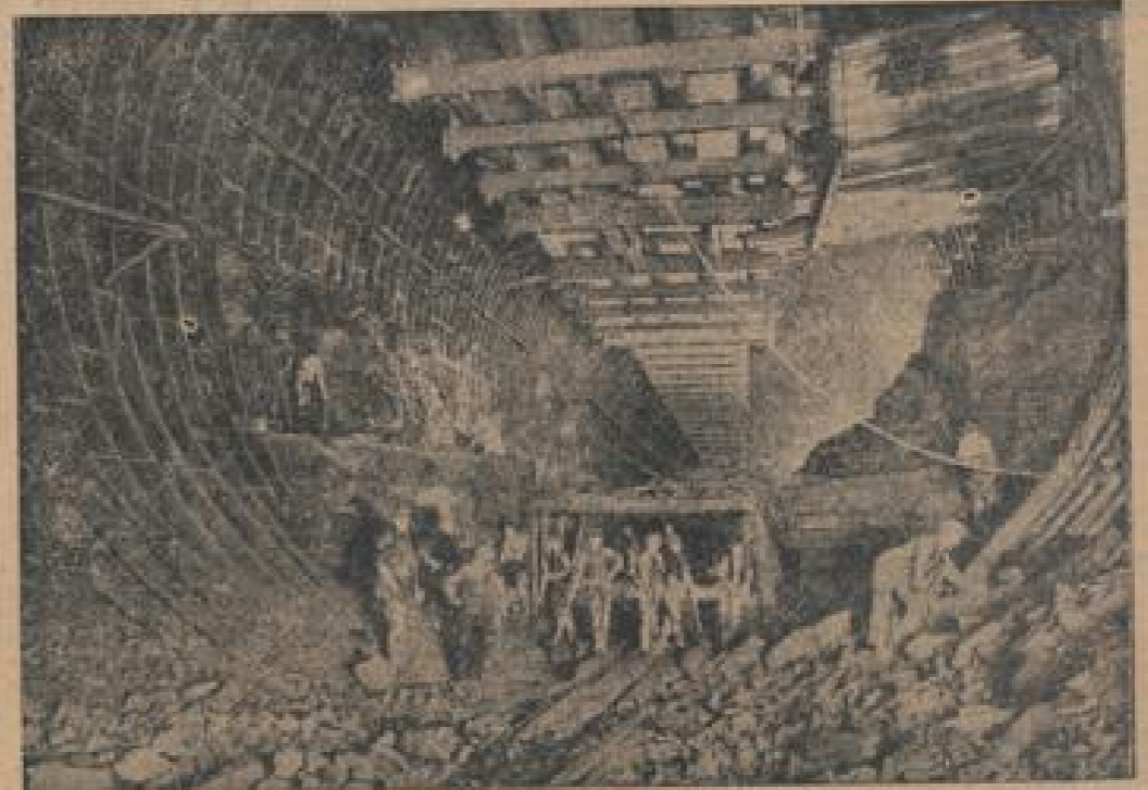
Baugarbeiten an dem Mersey-Tunnel zwischen Liverpool und Birkenhead in England. Dieser Tunnel, der den Juli 1933 beginnend Unterwasser-Tunnel zwischen den beiden Städten errichtet auf der Länge von 3 1/2 Meilen wird er den größten Unterwasser-Tunnel Europas darstellen.
