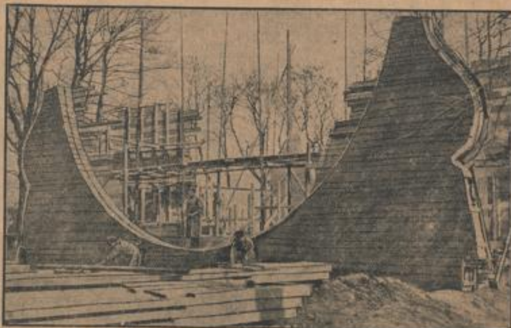
Das Holzgerüst, an dem die Konturen des Faßes bis zur Hälfte markiert sind...
