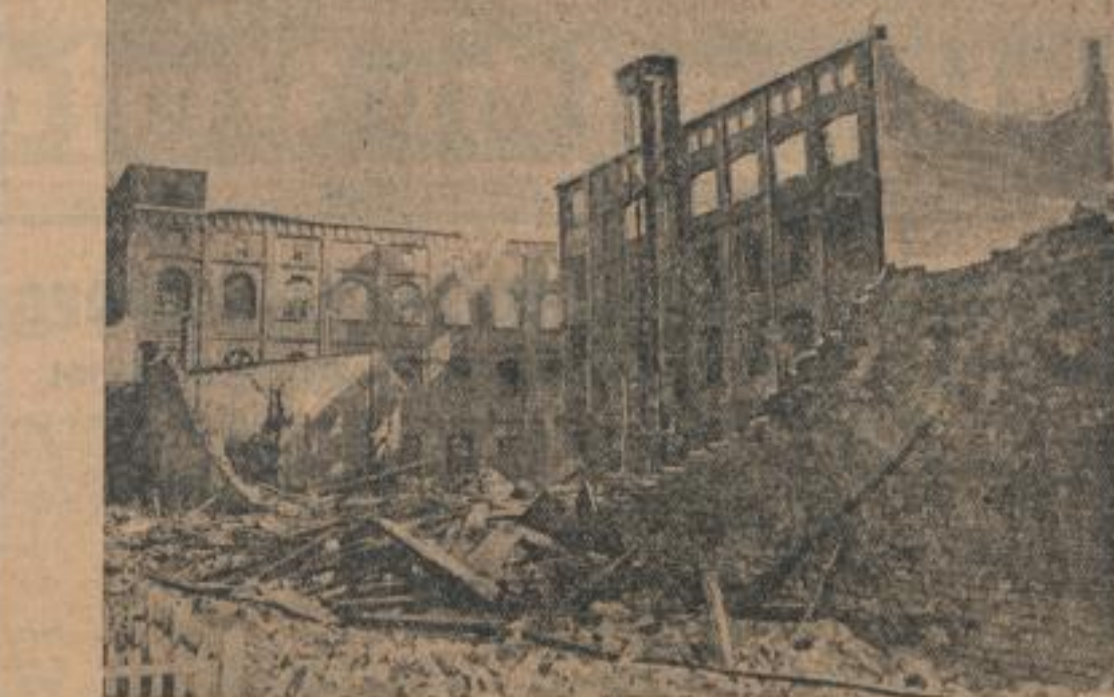
400 Feuerwehrlente standen in Berlin-Neukölln viele Stunden lang im Kampf gegen ein trüblich Schandfeuer, dem zwei Gebäude einer Fabrikfabrik zum Opfer fielen. Bei dem Brand, der das größte in Berlin seit dem Reichstagsbrand war, wurden drei der fünf höchsten anstehenden Pfeiler zerstört. 200 Arbeiter sind arbeitslos geworden.
