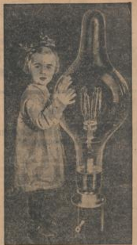
Größer als ein kleines Kind ist die Glühlampe, die auf der großen Show „Deutsches Volk — Deutsche Arbeit“ am Kaiserdam in Berlin gezeigt wird. Ihre Leistung beträgt 50 Kilowatt und ihre Lichtstärke ist 3700mal größer als die einer gewöhnlichen Haushalts-Glühlampe.
