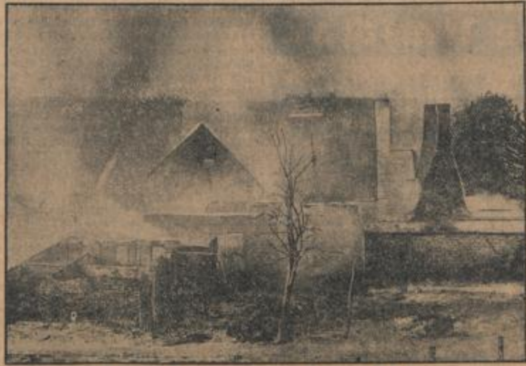
Die Brandruinen des Dorfes Carlshof bei Gollnow in Pommern, wo durch einen mit toller Geschwindigkeit sich ausbreitenden Brand 36 Häuser in Asche gelegt wurden.
