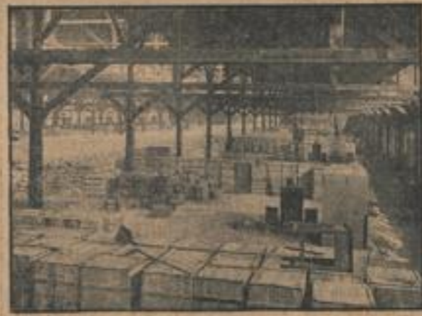
Inneres eines modernen Kaischuppens
