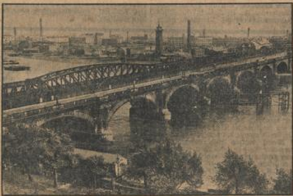
Die berühmte Londoner Waterloo-Brücke, deren Wiederaufbau durch einen Neubau für fünf Millionen veranschlagt ist, hat wieder in Kurze geschlossen. Durchs Interesse an den die alte Brücke restaurieren und über den Brücken. In London denkt man praktisch genau, um im Interesse der Sicherheit ein günstiges Angebot anzunehmen.
