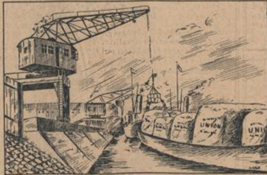
(Zeichnung von Hermann Otto Mannheim) Kranarbeiten im Mannheimer Hafen
