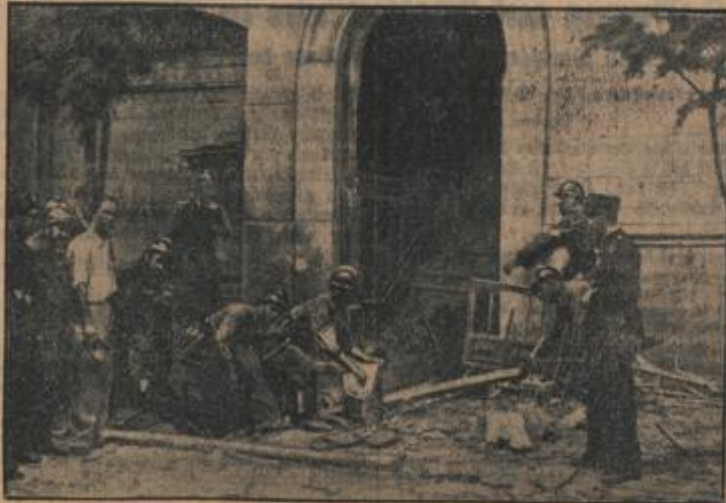
Generaleinsatz bei Aufräumarbeiten an einem Hause in San Sebastian, das eine Granate von den Gefolgten der nationalsozialistischen Kriegspartei vom Boden bis zum Keller durchschlagen hatte. (Wieland, R.)
