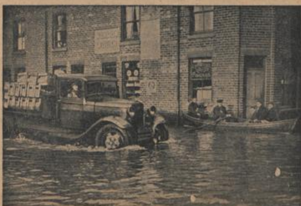
Auch in England wurden durch den Regen Überschwemmungen verursacht In Gillingford in der Grafschaft Dorsetshire können sich die Wagen mühsam den Weg durch die Wassermassen, und der Verkehrsverkehr wird durch Bäume aufrechterhalten. (Pfeife-Hoffmann, Jander-M.)
