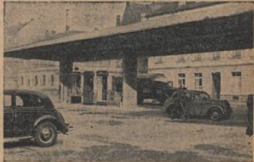
Die Tankstelle mit der konstruktiv originellen Holzüberdachung
