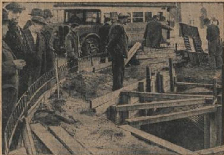
Die Luftschutttunnel, die gegen der South Kensington Station in London gebaut wurden, haben jetzt vor der Fertigstellung. Große Stahlrahmen wurden in die ausgehöhlten Wände gelegt und später mit Erde und Beton zugedeckt. — Unter Bild zeigt im Vordergrund eine der Stahlschutttunneln, die in der Erde. Im Hintergrund ist ein Arbeiter beim Bedecken der Wände mit Sand zu sehen. (Associated Press, London-Bl.)
