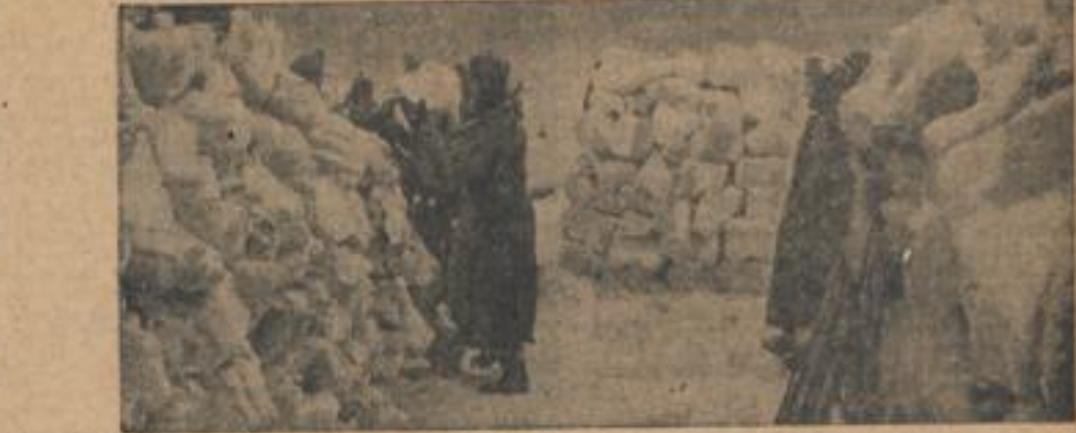
Schneemauern schützen vor Schnee An Straßen, an denen die Gefahr von Schneeeinwirkungen besonders groß ist, werden sogenannte Doppelmauern errichtet...
