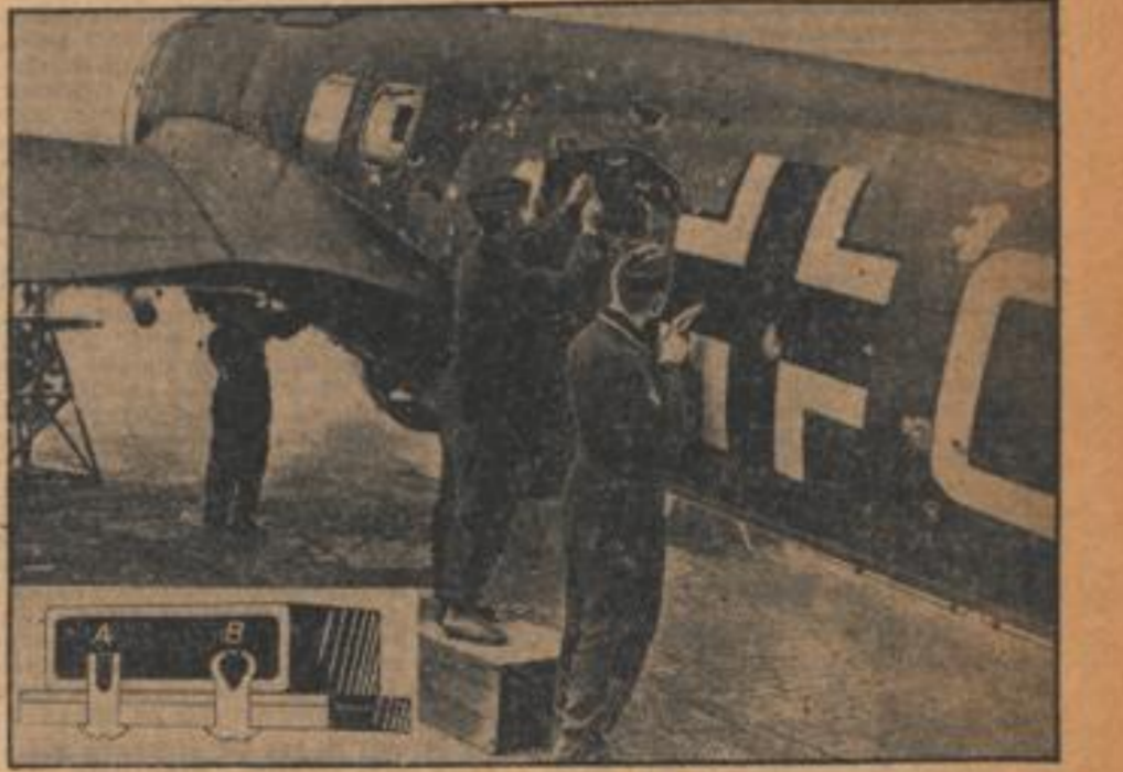
Schulöcher in der Außenhaut einer He 111 werden in der Frontreparaturwerkstätte in kürzester Zeit durch Sprengnieten repariert. — Links unten: A) Eine Niete, B) eine Niete nach der Nieten.
