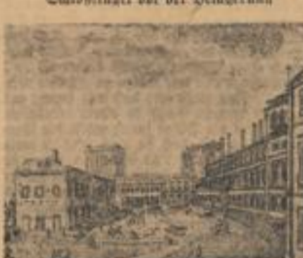
Schloßflügel nach der Belagerung
