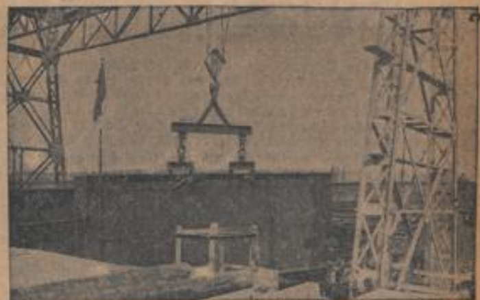
Einsetzen des Schlußstückes in die Friedrich-Ebert-Brücke
