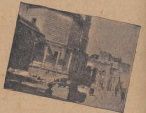
Ruinen vom Palast Diokletians in Spalato Phot. Victor Bergold-Mannheim
