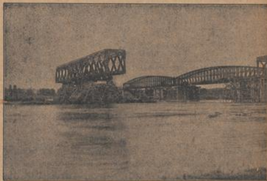
Bau der neuen Eisenbahnbrücke über den Rhein bei Wesel Presse-Photo G. m. b. H., Berlin
