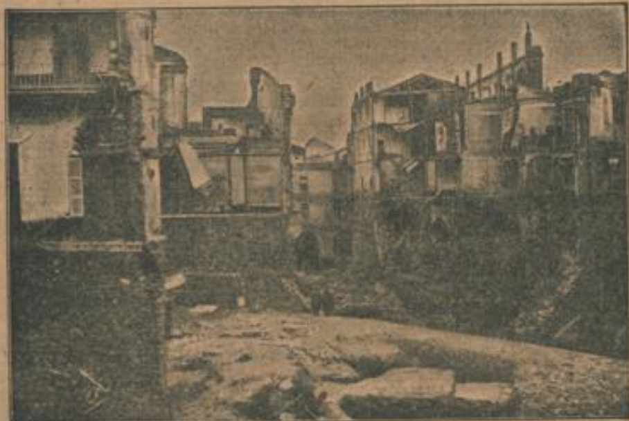
Wirkung der Riesennüberschwemmung in Algerien Atlantische Paris
