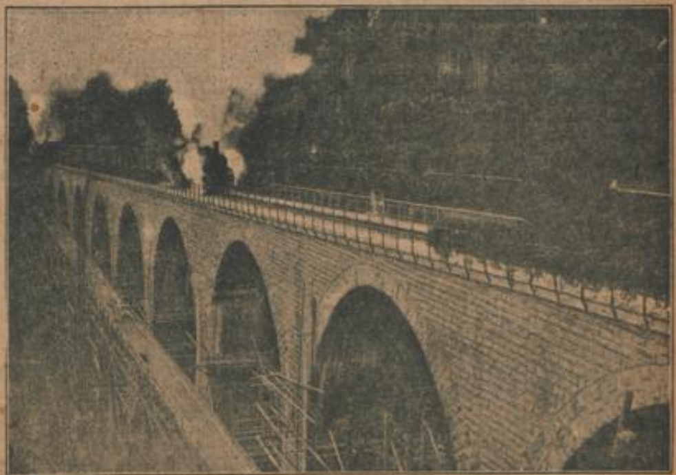
Der erste Zug auf dem neuen Viadukt über die Ravennaschlucht (Höllentalbahn) Deutsche Presse-Photo-Zentrale Berlin.
