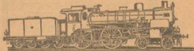
3/4 Heißdampf-Lokomotive S6 der Preuß. Staatsbahn
