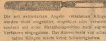
Die mit extra starken Angeln versehenen Klappen werden nicht eingeklinkert, eingeklinkert nicht vernietet, sondern mit einer Metallkomposition nach eigenem Verfahren eingegossen. Das Auswechseln von schadhaften Klappen macht keine Schwierigkeiten.
