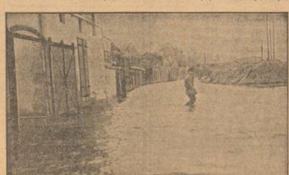
Der entsetzliche Sturmchaden der letzten Tage hat überall an der deutschen Nordseeküste (hierzu) Unheil angerichtet. In allen Straßen sieht man die Häuser zerstört und nicht vor allem in den Kellern die schwarzen Schalen an.
