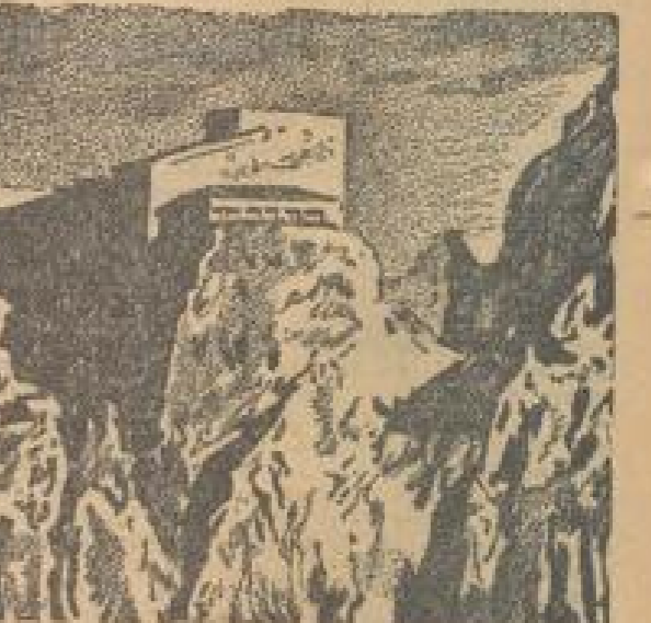
Die Endstation in fast 3000 Meter Höhe. Der schmale Gipfelgrat bietet kaum Platz genug für die große Zahl von Personen, die die Bahn zu befördern vermag.
