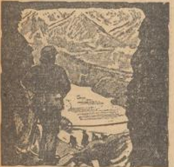
Durchblick von „Fenster 4“ auf den Riesensee. Zum Schutz gegen Steinsehlagen mussten Arbeiter und Ingenieure mit Stahlhelmen ausgerüstet werden.
