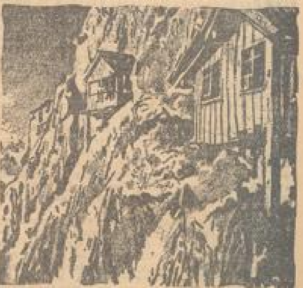
Wie Adlerhorste hängen die Hilfsbauten in schwindelnder Höhe an der Felsenwand.
