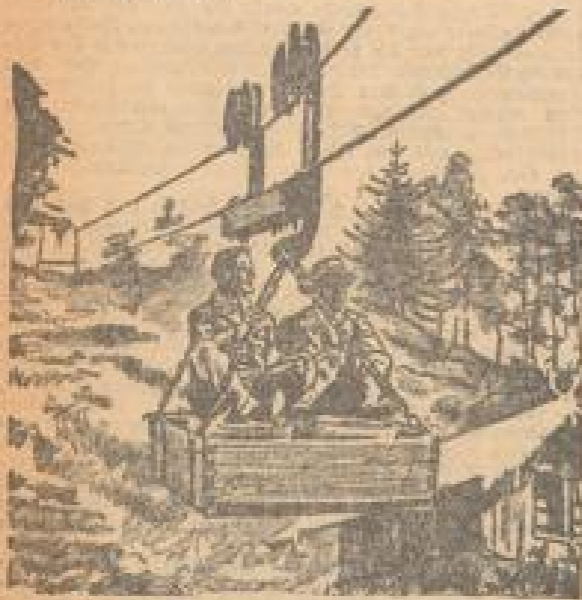
Mit der Seilbahn zu den Arbeitsstätten. Während der Bauzeit bildeten solche Förderketten die einzige Verbindung mit den „Fenstern“.
