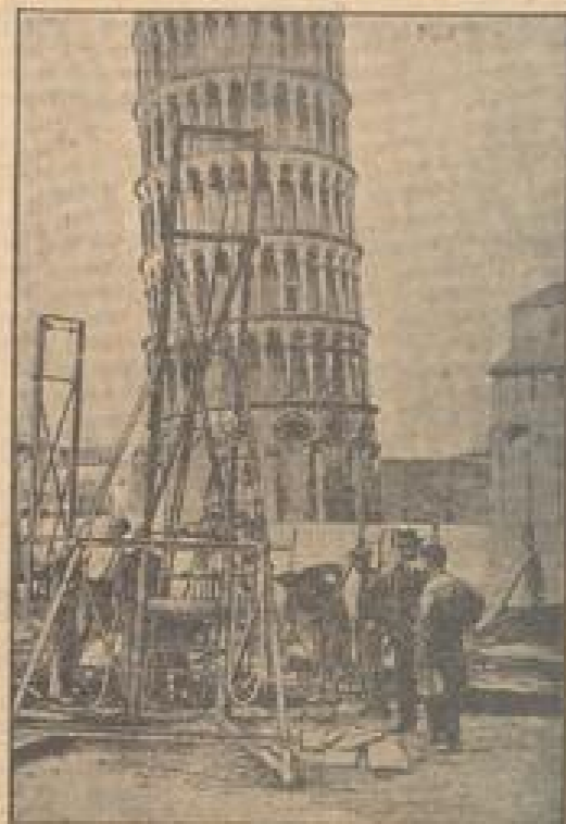
Einsetzen des Zements in die Umgebung des freilegenden oberen Glockensturms am Turm zu Pisa, der durch Einsturz von Wasser in das Fundament gefährdet ist.
