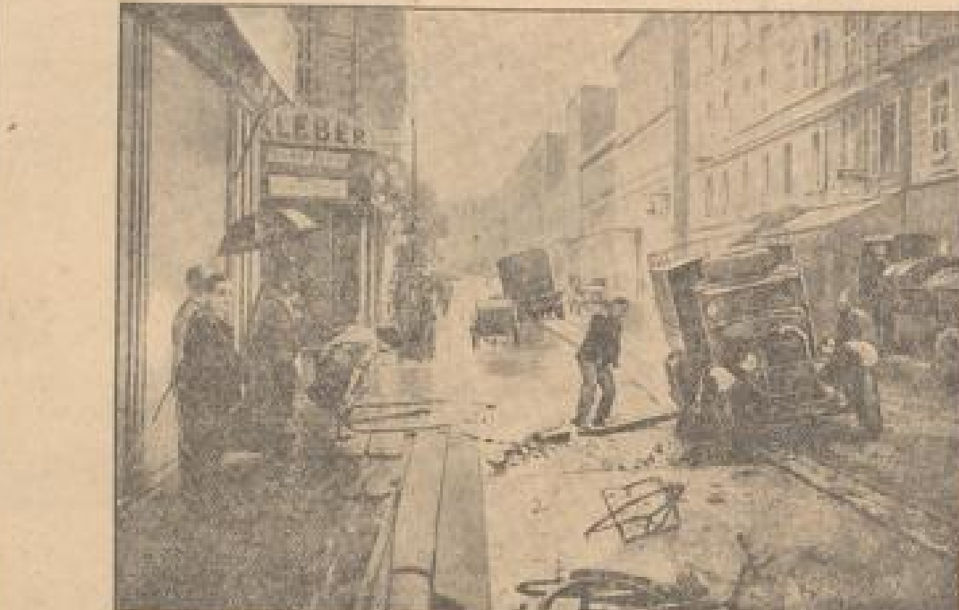
Nach dem Unwetter: Die Wassermassen haben die Straßendecke aufgerissen. Nizza, der elegante Kurort an der französischen Riviera, wurde von einem mit ungeheurer Gewalt verbundenen Gewitter heimgesucht, bei dem die Scherben der Straßendecke aufgerissen und teilweise weggeschwemmt wurden.
