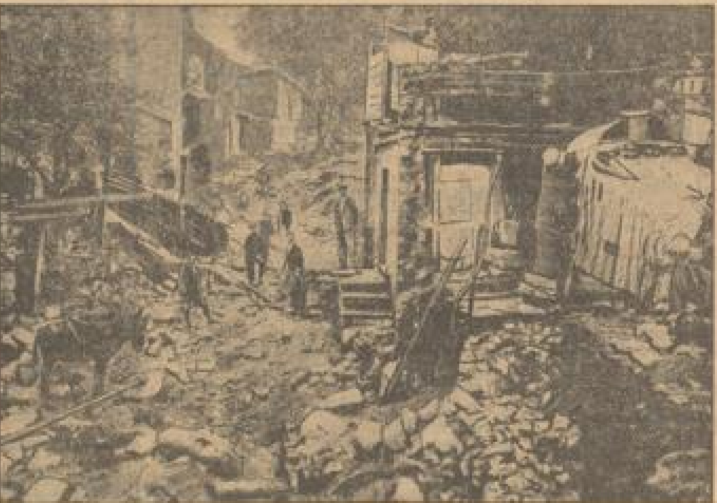
Häuser in Smyrna, die von einer Feldflamme zerstört wurden
