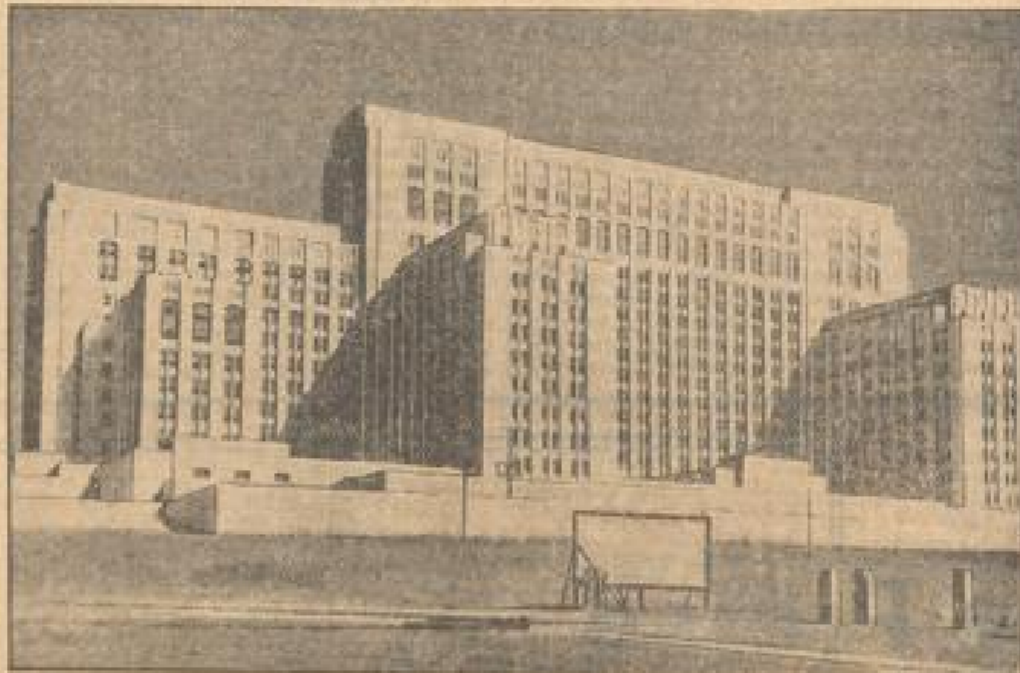
Der imposante Krankenhaus-Bau von Los Angeles vor der Eröffnung. Der umgebene Bau, der mit einem Rohbauwert von 20 Millionen Dollar erbaut wurde, kann 5000 Kranke aufnehmen. Die Anzahl der Krankenzimmer beträgt 5 Jahre.
