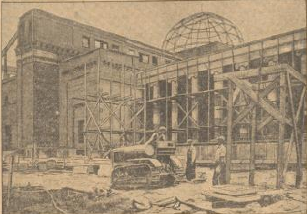
Umbau des alten Field-Museums.
