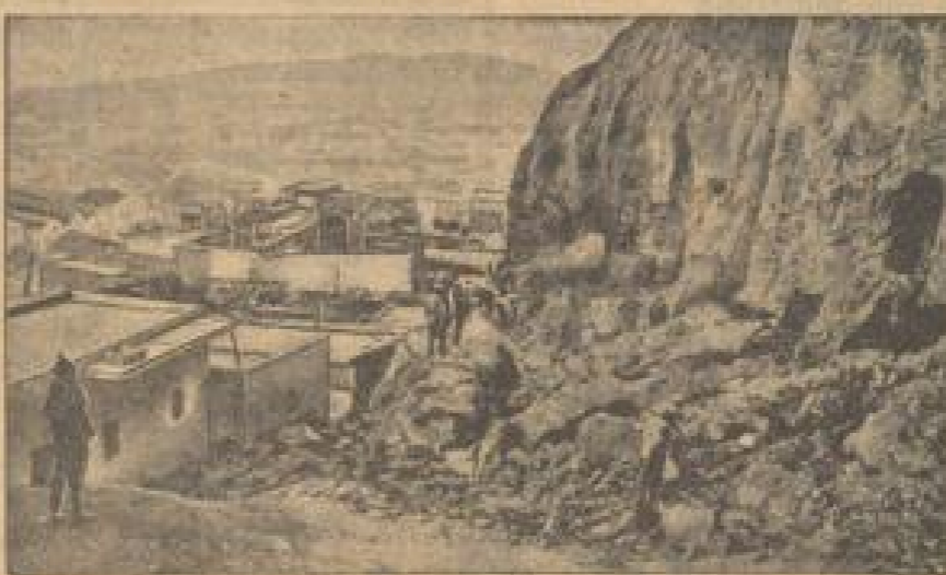
Blick auf die Einsturzstelle
