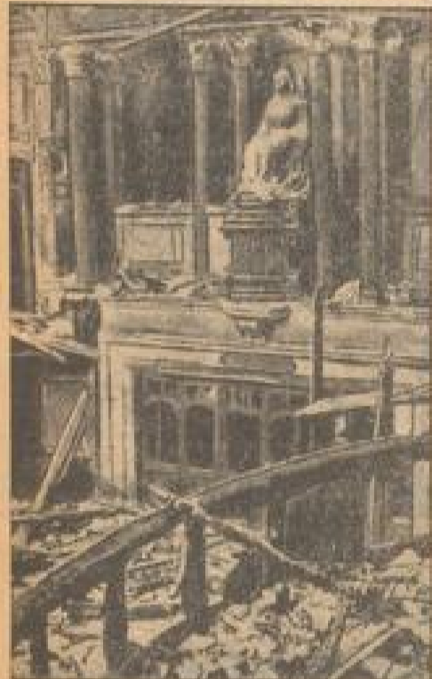
Der ausgebrannte Theaterraum des Volkspalastes
