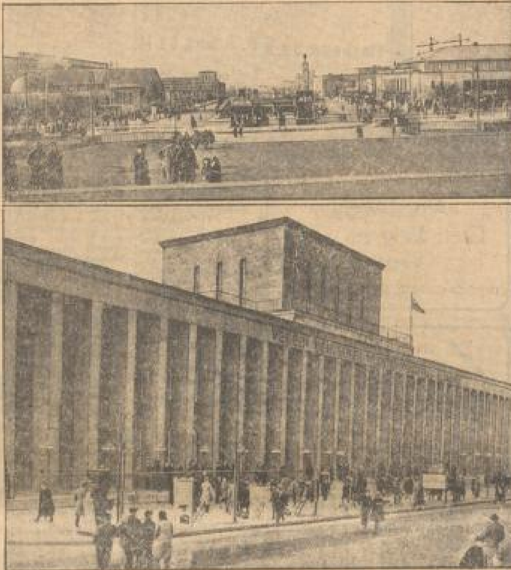
Oben: Das Gelände der Leipziger Technischen Messe. Unten: Halle der Werkzeugmaschinenfabriken
