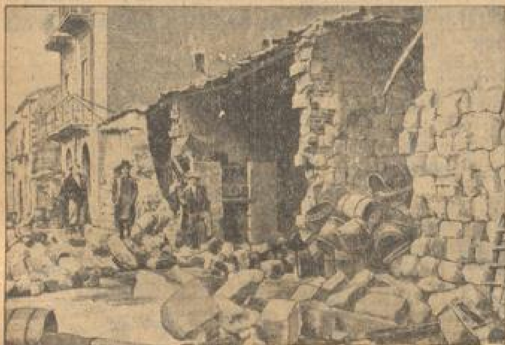
Ein Wohnhaus in Palermo, das völlig unterspült und zum Einsturz gebracht wurde...
