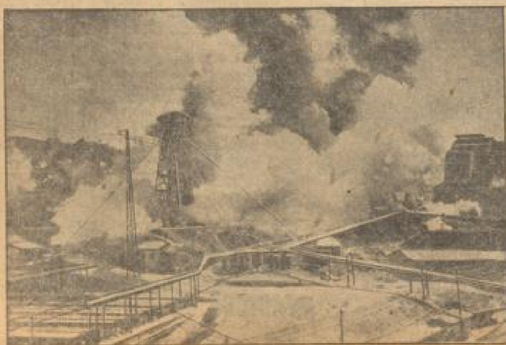
Der Erdgasausbruch bei Bohrarbeiten in Cardorello (Italien)
