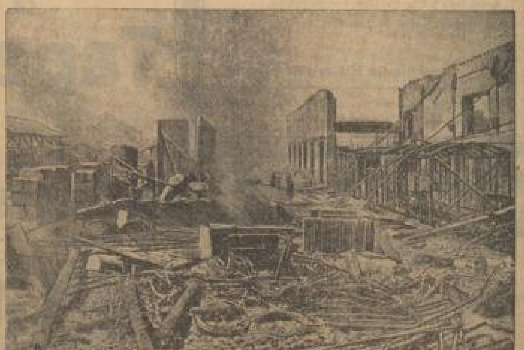
Der ausgebrannte Bahnhof Senfer-Grenzwasse.
