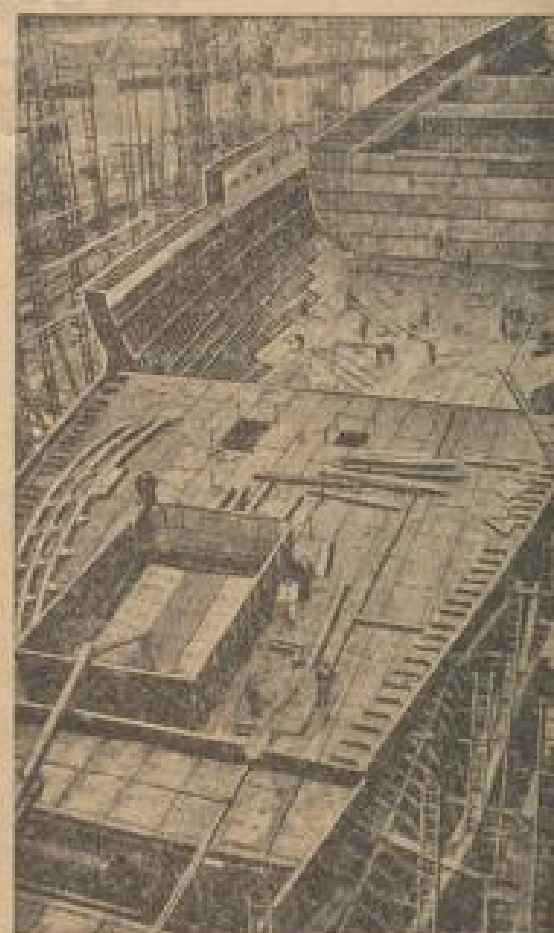
Der 73 000 t-Dampfer der Cunard-Linie im Bau
