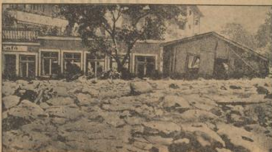
In den Straßen von Kaprun, dem kleinen Schladinger Ort bei Salzburg, liegt das Meer aus dem Schlamm unterhalb. Viele Häuser wurden von der Gewalt der Schlammlawine schwer beschädigt.
