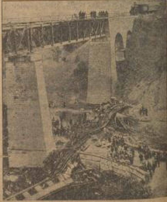
Das Stadtkirch von Batorbágy mit dem heruntergestürzten Waggon.
