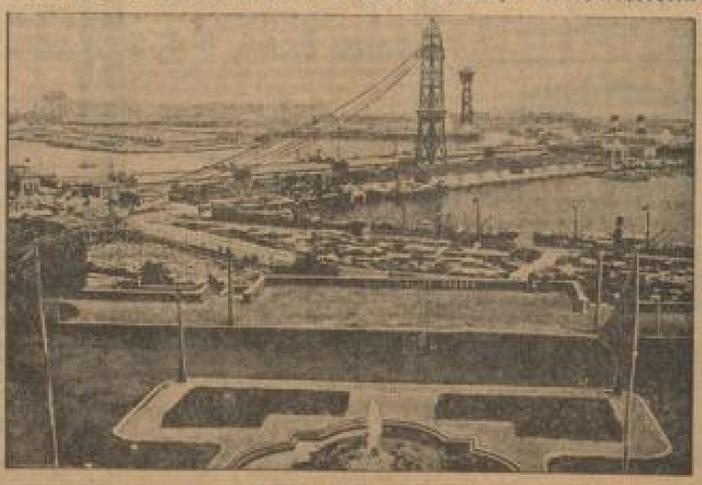
Blick auf die Anlagen der riesigen Seilseilbahn, die bei der Barcelona-Exposition 1929 mit dem Berg Montjuich bei Barcelona verbunden. Die Stationen der Bahn liegen auf Höhen von 70 bis 100 Meter über dem Meeresspiegel. Die Seilbahn ist 1,5 km lang und hat eine Seilbahn, die 100 Meter beträgt, in eine neue Seilbahnstation bei Barcelona.
