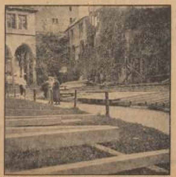
Auf dem Rasen der Spielfläche und vor der Brunnenhalle lagern sich noch Balken und Bretterstöße für die Tribünen.
