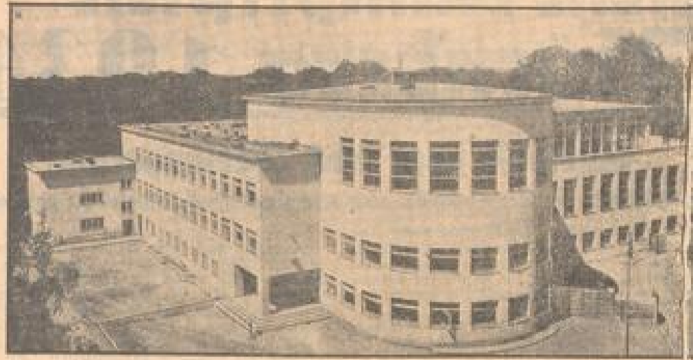
Der Neubau des Anatomischen Instituts, das das größte und modernste Europas ist, wurde jetzt fertiggestellt. Der Bau wurde im Jahre 1927 begonnen und kostete 1,7 Millionen RM. Der Neubau, dessen Eigenart amphotischen angeordnet ist, bietet Raum für 200 Lehrer.
