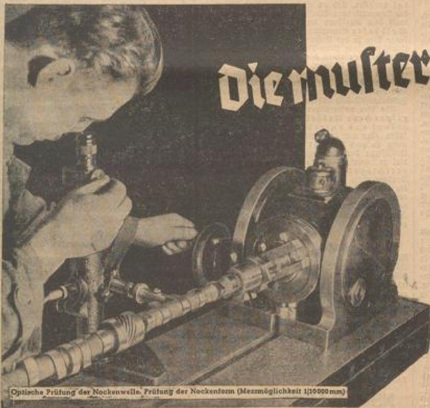
Optische Prüfung der Nockenwelle. Prüfung der Nockenform (Messmöglichkeit 1/10000 mm)
