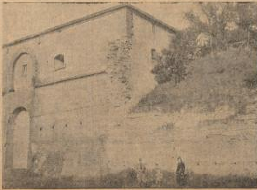
Hier ist gesprengt worden!
