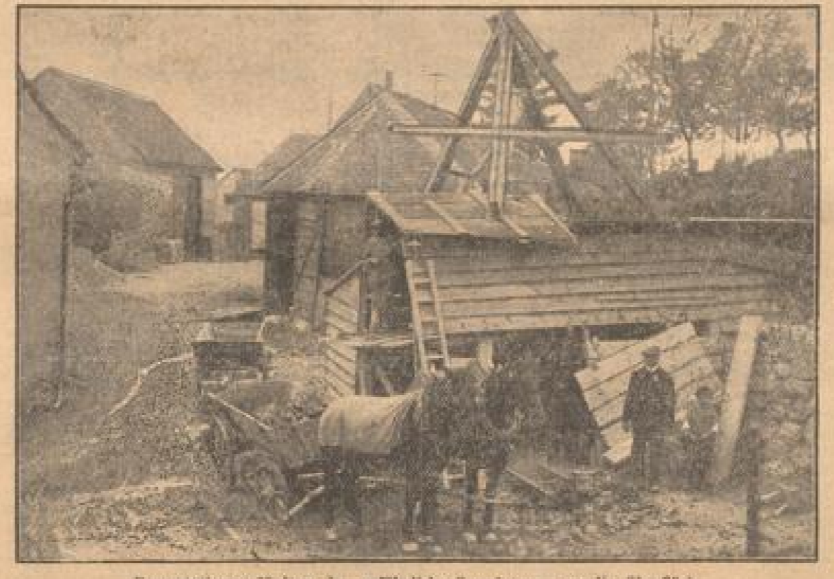
Pumpstationen fördern das gefährliche Grundwasser an die Oberfläche
